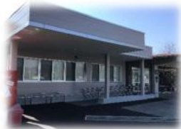
屋根付き車輻停車場
